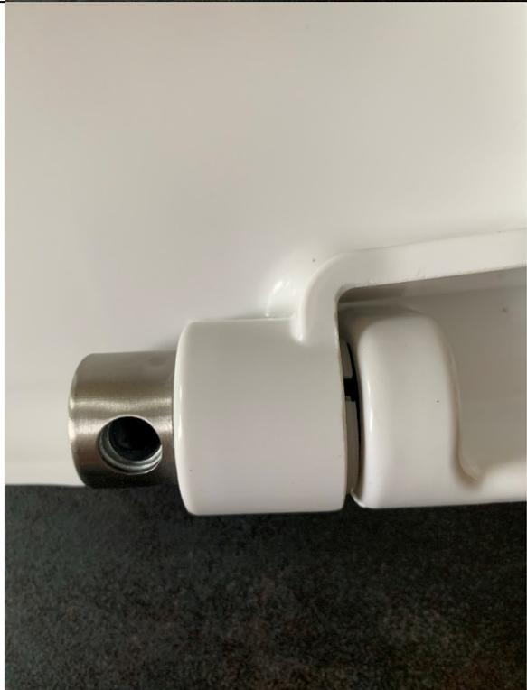
Nun hebeln Sie den Ring mit dem spitzen Werkzeug soweit raus, bis Sie ihn greifen können. Durch die Flexibilität des Kunststoffs lässt sich der Ring ganz leicht rausziehen.
